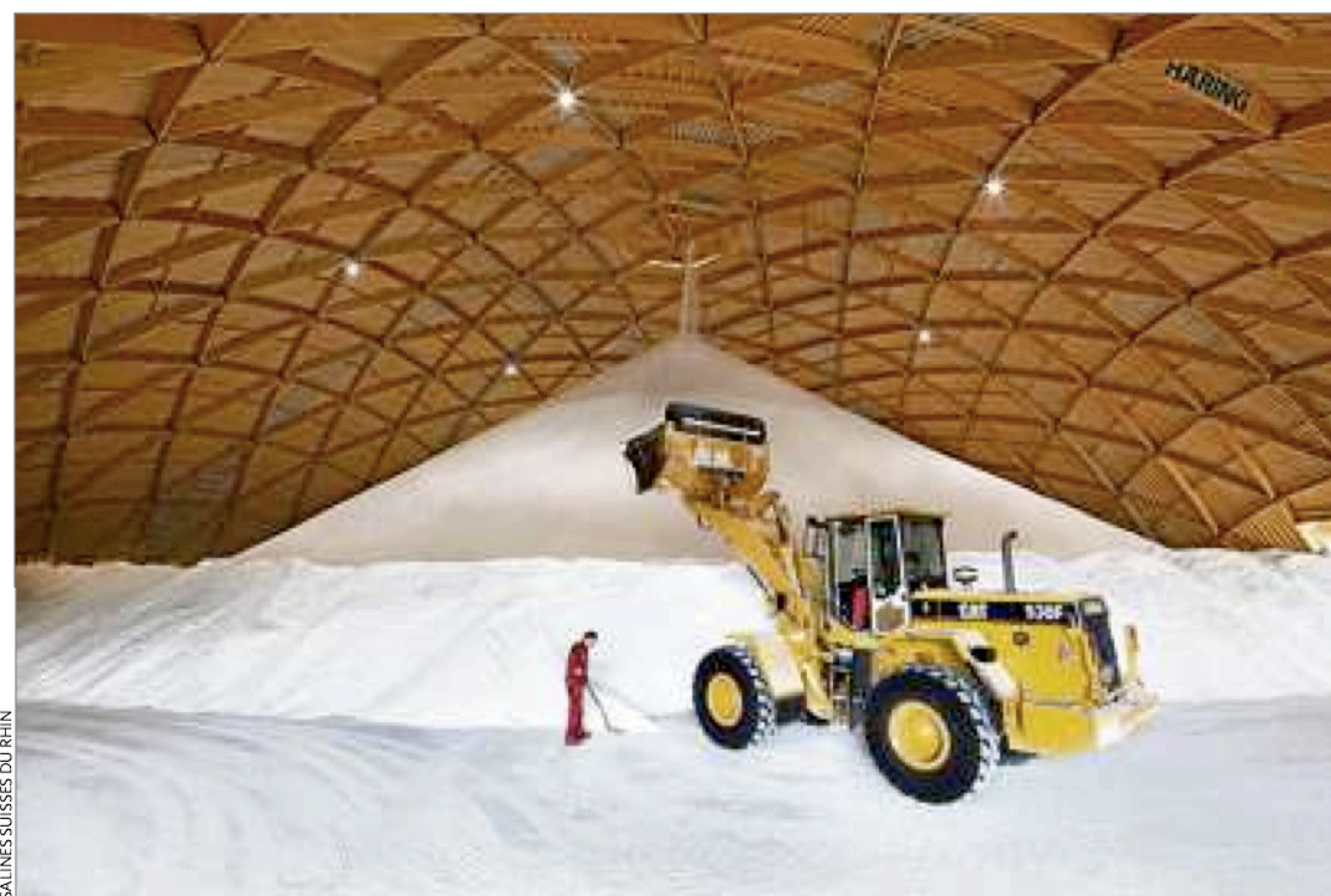
Entrepôt des Salines Suisses du Rhin. L'entreprise est le plus gros producteur de sel de la Confédération. Elle approvisionne tout le pays à l'exception du canton de Vaud qui se fournit dans la Saline de Bex. RIBURG
